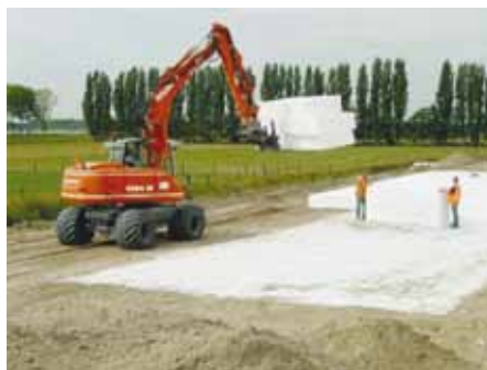
▲ Szwecja – styropian jako podbudowa drogi
